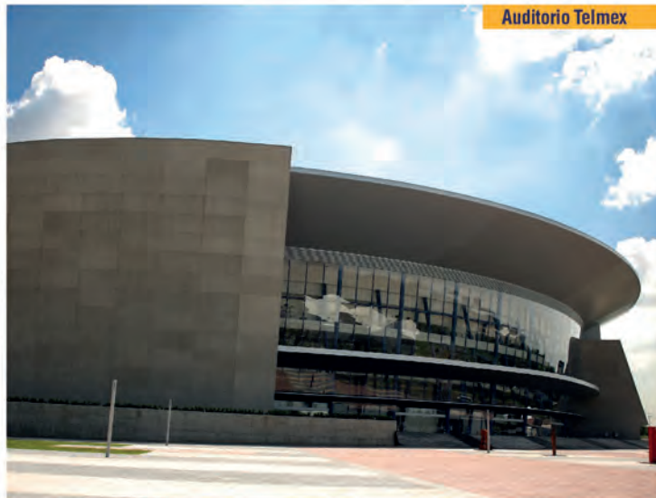
Muro Gris Martelinado
