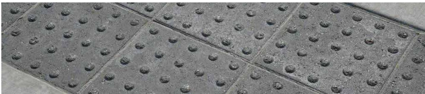
Los **adoquines táctiles** son útiles como guía para los peatones invidentes o con visión parcial. La geometría de adoquines con superficies que se pueden detectar fácilmente al tacto indica dirección y alerta de frenado por un riesgo próximo. De igual manera sugieren como elementos antiderrapantes. Se fabrican en textura puntual y lineal.
