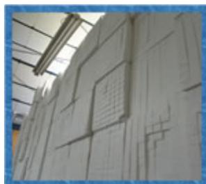
El Panel MG es un panel constructivo modular, consiste en una estructura tridimensional de alambre de acero pulido al bajo carbono (1008), normas ASTM A-82, A-85, A-370 y A-510, calibre 14 o 13, conformada por armaduras de dos alambres paralelos electrosoldados a un tercero en forma de zigzag conformado así retículas en la parte inferior y superior del Panel MG.
